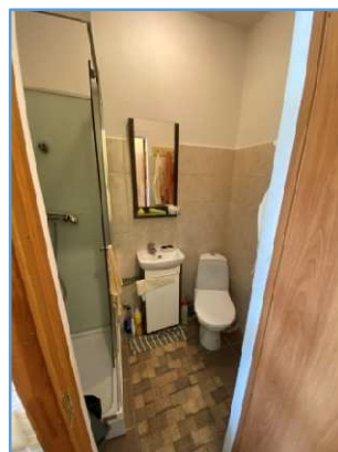
Skats uz savienoto sanitārtehnisko telpu
